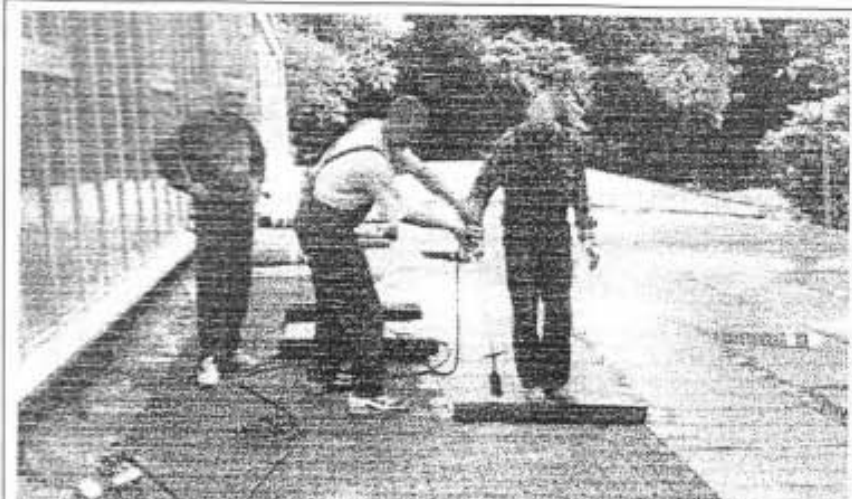
Bild Nr.: 89 - Beim Auftragen der Dachpappendeckschicht auf dem Hallendach August 1997. v.l.n.r.:
